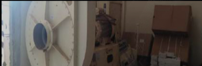
Fan Blower Fabrication & Installation
